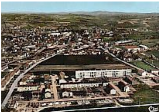
Vue aérienne du quartier de Pratviel en 1961.
